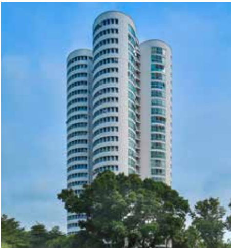
Clover Blocks at Ang Mo Kio.
